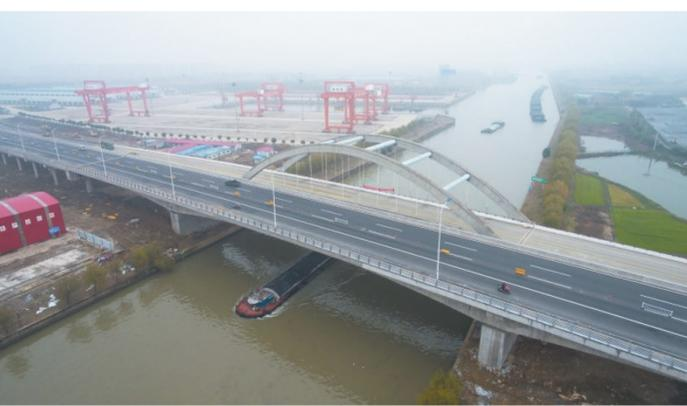
国内首例整体顶升大跨径钢管砼系杆拱桥——宁杭高速南河特大桥左半幅日前通车运行。大桥跨越光中运河，因通航净高度不能满足三级航道通航标准，故对桥梁整体顶升2.16米。
