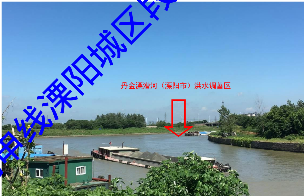
图 4.2-3 本项目涉及的丹金溧漕河（溧阳市）洪水调蓄区现状
